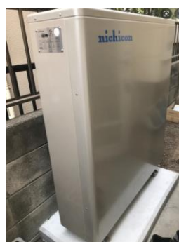
リチウムイオン蓄電池 (16.6kWh)
